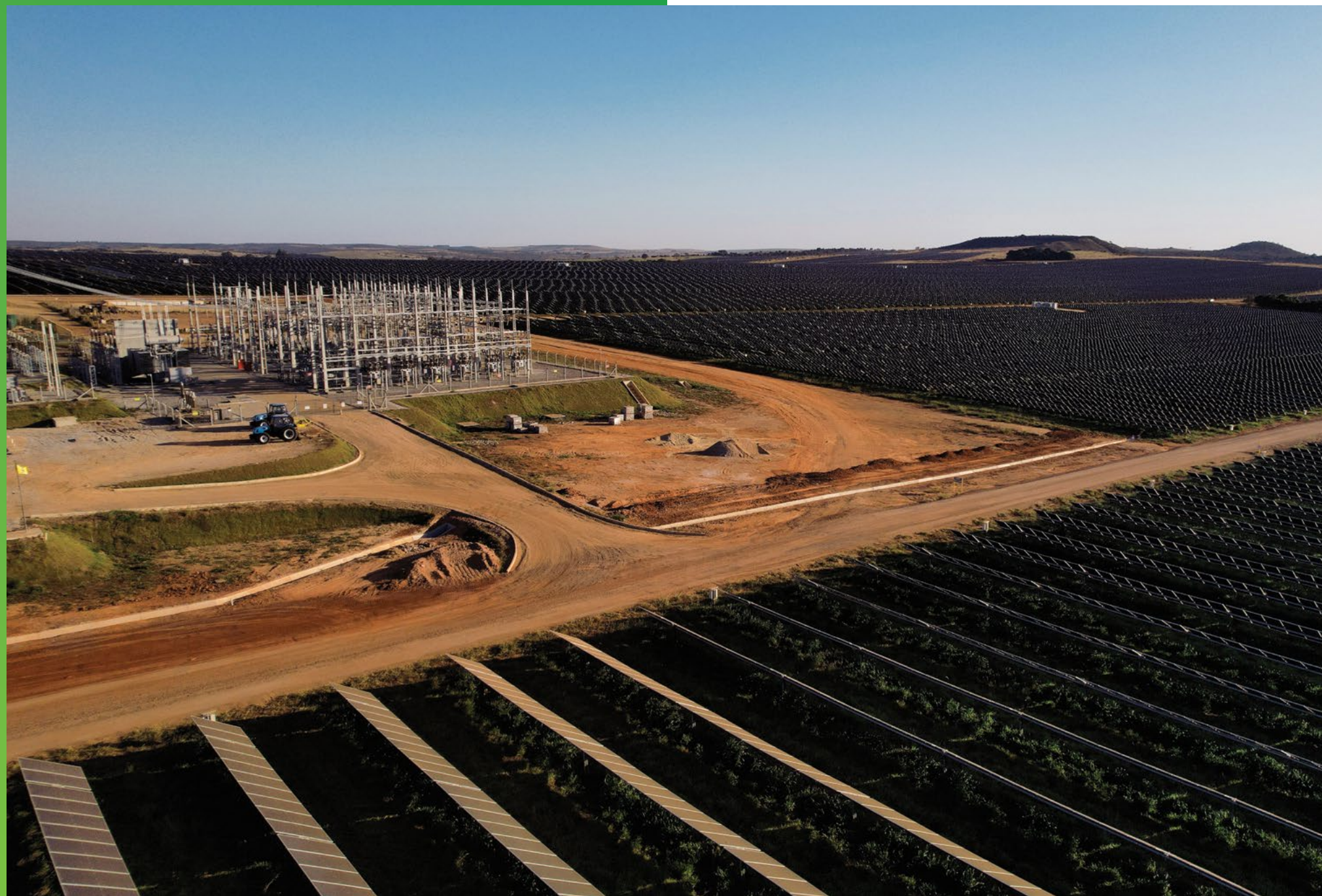
Complexo Solar Boa Sorte e a Subestação
