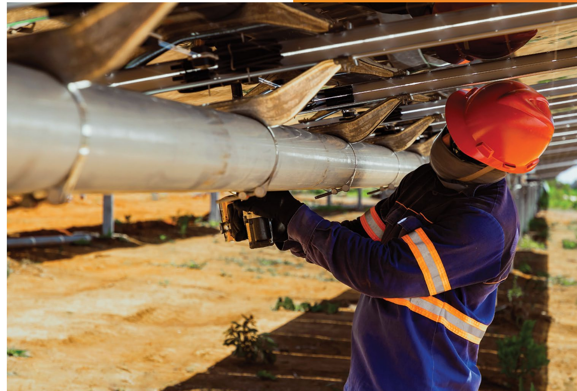
Colaborador fixando um painel fotovoltaico
